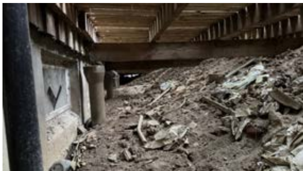
Under terrassenivå på baksiden. Vindu er defekt. Terreng heller innover.
