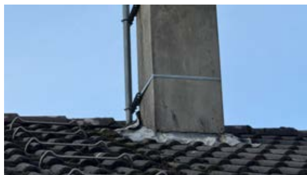
Piper kontrolleres over tak, ingen sprekker registrert utvendig.
