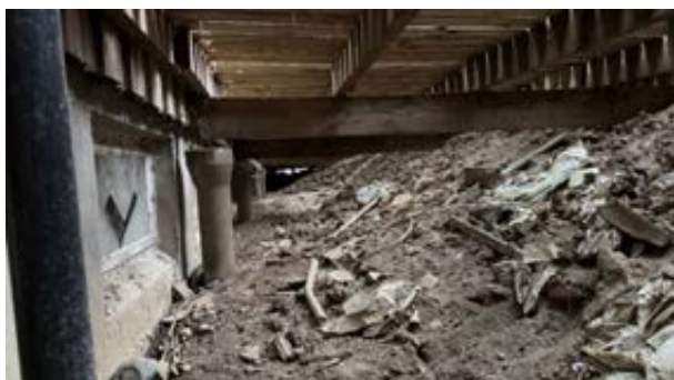
Innovherhellende terreng mot grunnmur.
