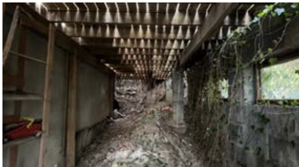
Under terrassenivå på baksiden. Vindu er defekt. Terreng heller innover.
