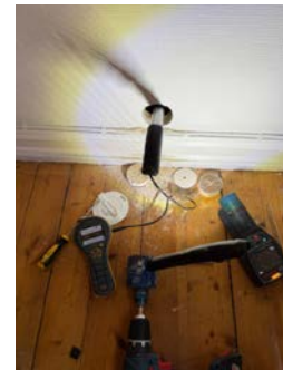
Hulltagning med pigger i svill uten unormale utslag
