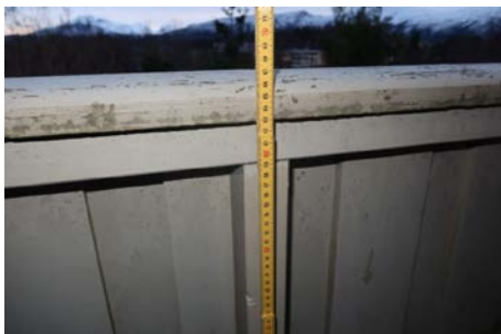
Lavt rekkverk veranda syd.
