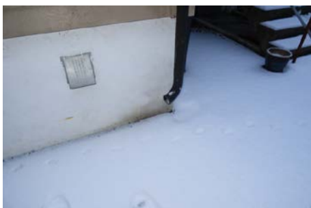
Det er ikke tilfredsstillende bortledning av vann fra taknedløp ved grunnmur.
