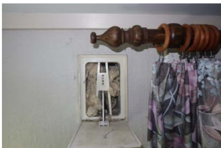
Veggventil tett med papir.
