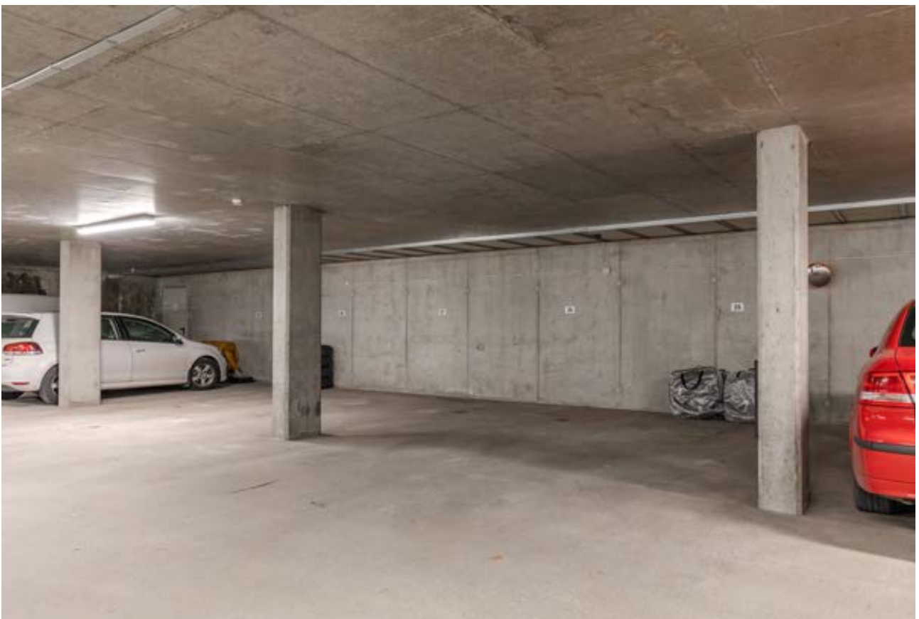
Fast p-plass i lukket garasjeanlegg. Det er mulighet for å installere el-bil lader på plassen.
