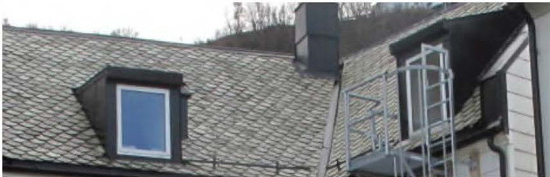
Kobbhus mot bakgård (branntrapp synlig til høyre vil være gjenstand for egen søknad)
