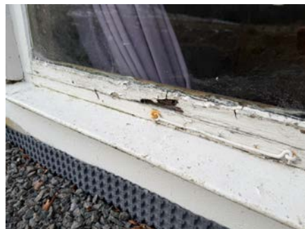
Råteskadet kjellervindu.
