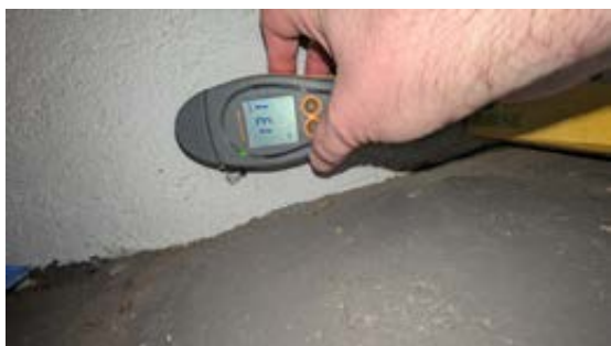
Fuktmåling på vegg i boden. (tørt)
