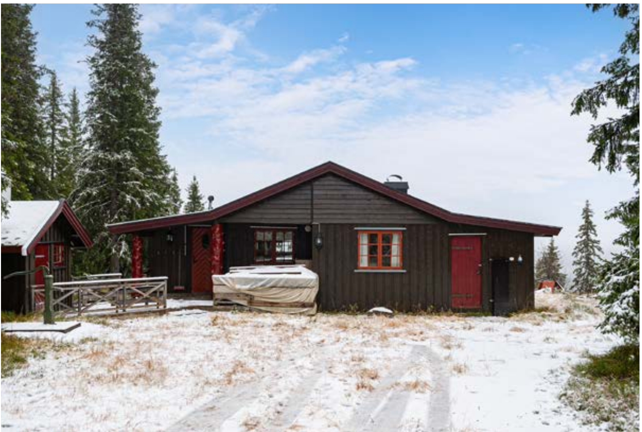
Bygningen har stående og liggende panel samt vinduer med koblet glass, sist modernisert i 2007 (kilde: tilstandsrapport).
