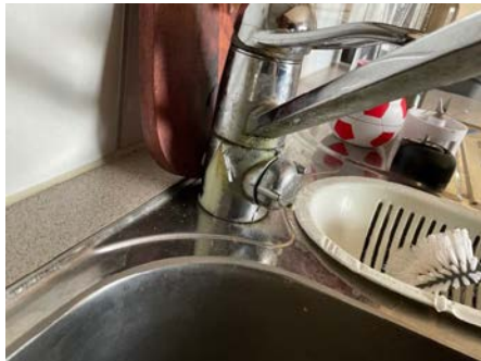
Kranen er låst i en posisjon og det er en sprekke i kranen.
