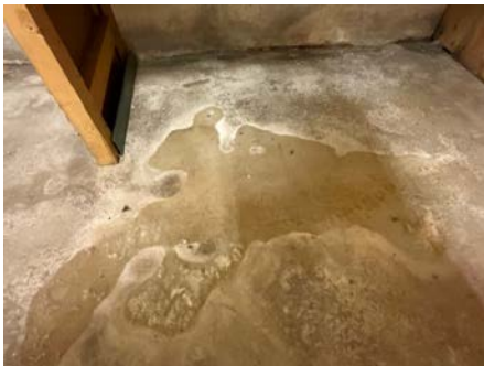
Saltutslag i gulv i underetasjen mot vest.
