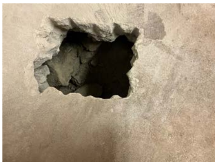
Det er tatt hull i platen for å se hvordan den er bygget opp.
