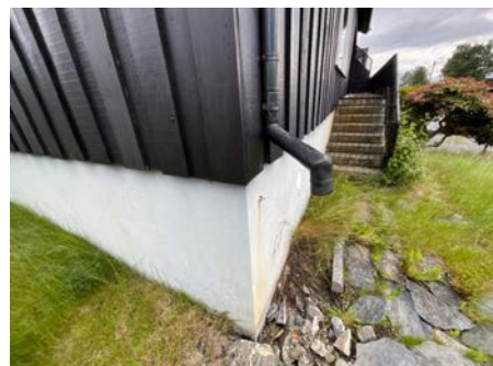
Nedløp renner ut ved yttervegg.
