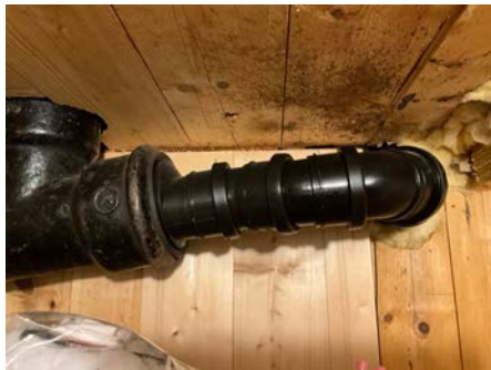
Kombinasjon av plastrør og støpejernsrør.
