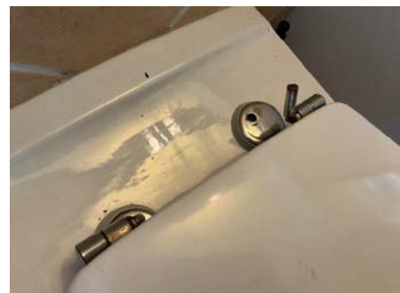
Hengslen på toalettsetet er ødelagt.
