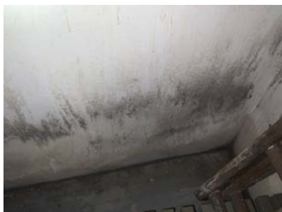
Råteskade på lettskillevegg
