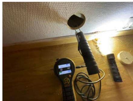
Fuktsøk og fuktmåling.
