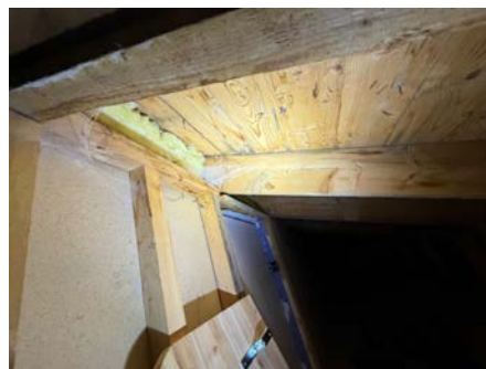
Eksempel på fullisolerte sperrerom.
