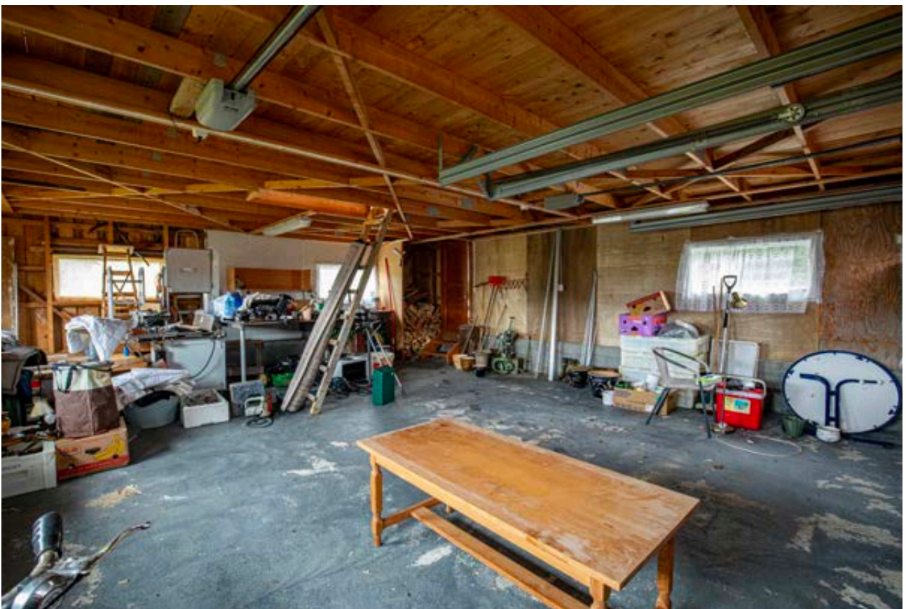
Betonggulv i garasjen gir robust underlag for oppbevaring og verkstedaktiviteter
