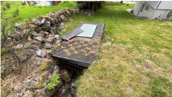
Bekk går inn i rør, rett ved tomtegrensen.
