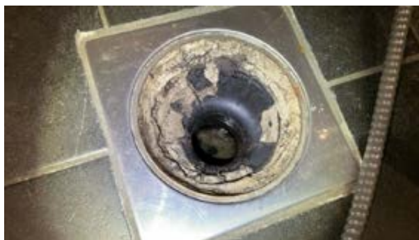
Sluk bad på loft
