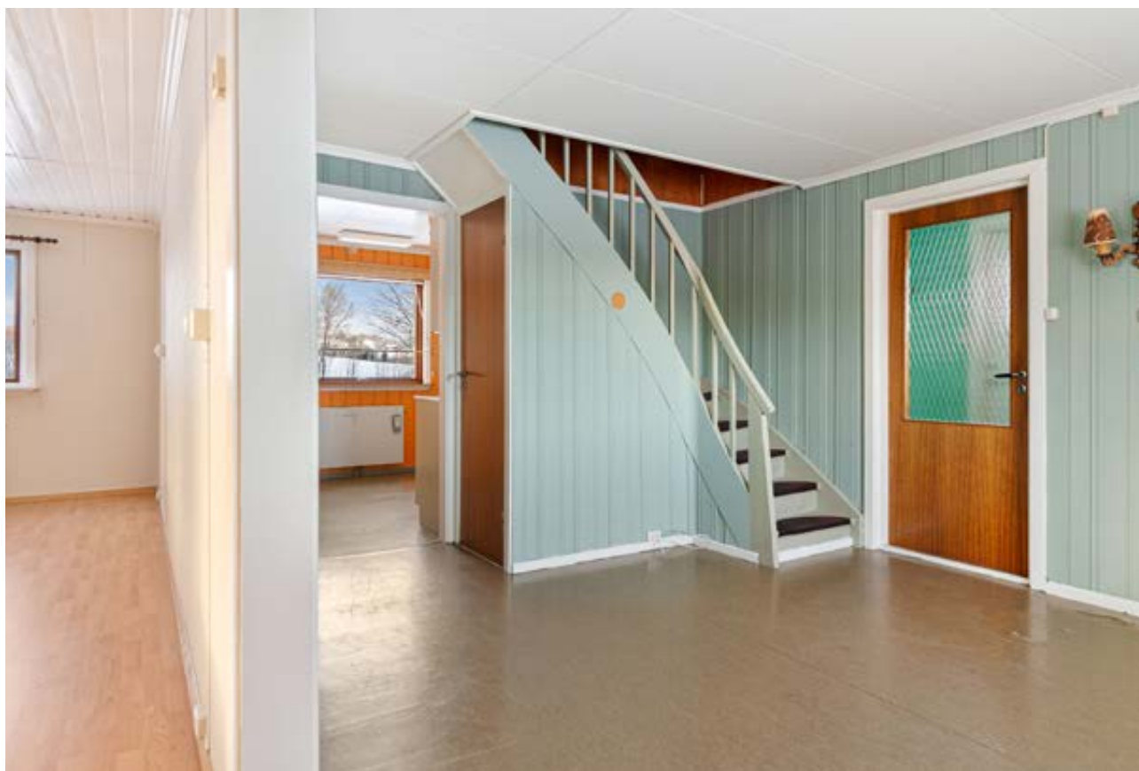
Gulvet er dekket med belegg, og veggene har malt panel, som gir en slitesterk overflate.
