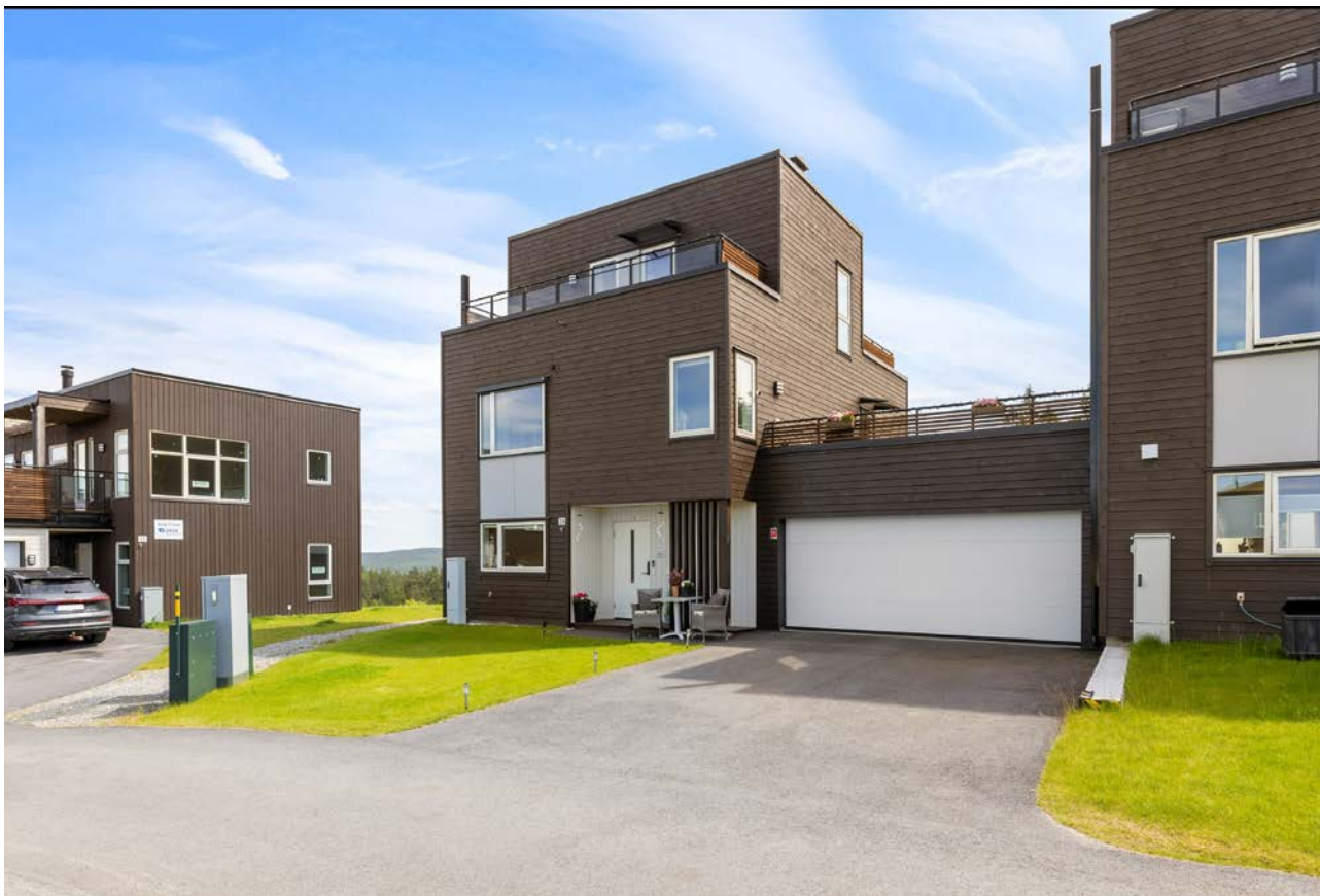
Dobbelgarasje med elektrisk port og elbil-lader. Garasjen fører videre til praktisk bod og adkomst til hagen.
