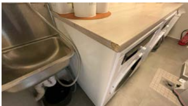
Det er en skade på lamineringen på siden av benkeplaten.
