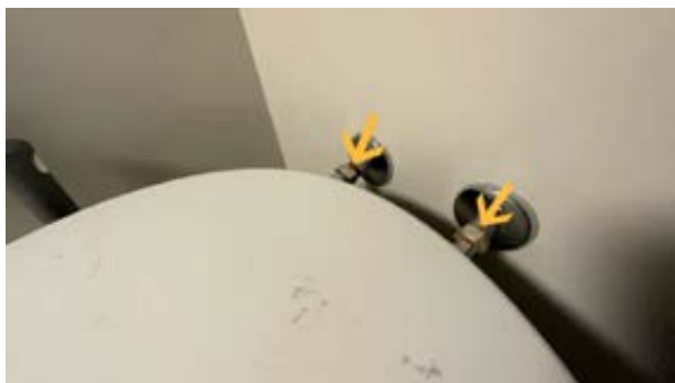
Irning rundt rør.
