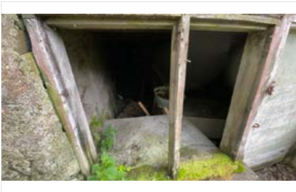
Bilde 10: Bilde tatt gjennom vindu i kjelleretasje.
