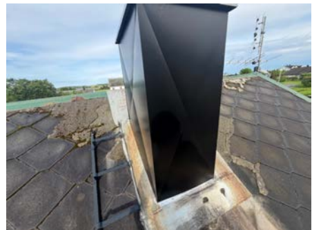
Skorstein ovet tak.
