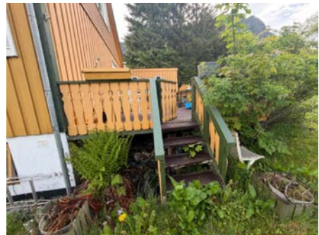
Oversiktsbilde av veranda.
