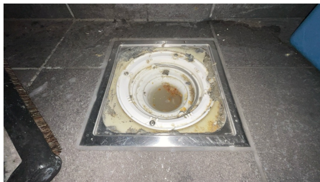
Kontroll av sluk.
