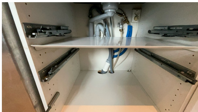
Besiktigelse av røropplegg.
