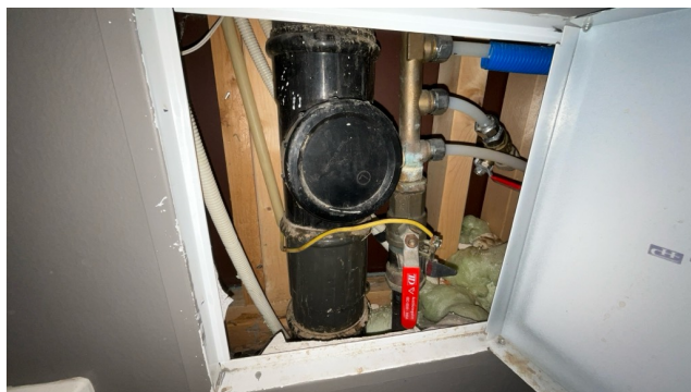
Besiktigelse av røropplegg.
