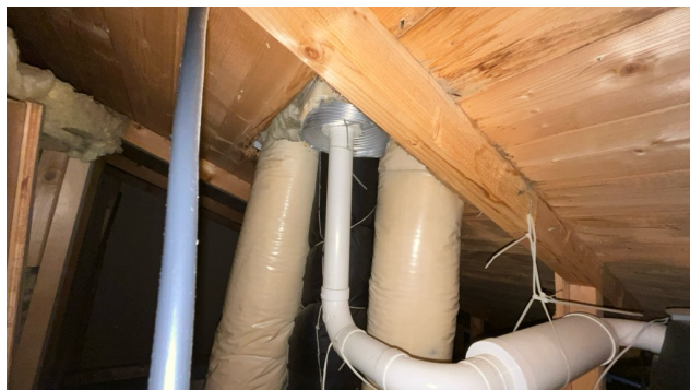
Kontroll rundt rørgjennomføringer.
