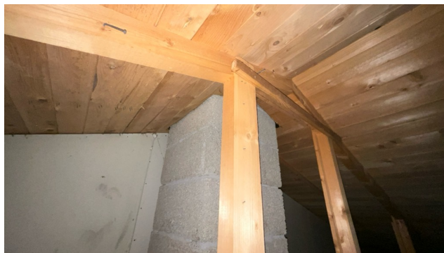
Kontroll rundt pipeløp.
