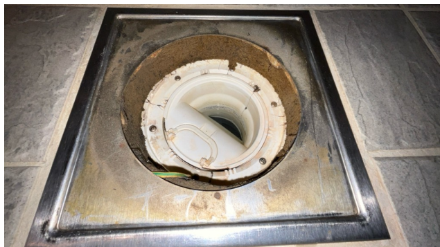
Kontroll av sluk.
