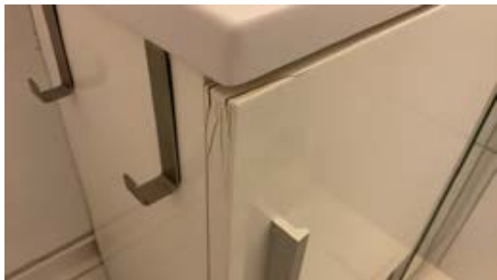
Skade på frontdør servantskap.
