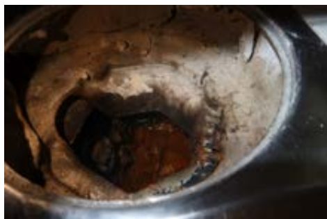
Støpejernssluk fra byggeår.
