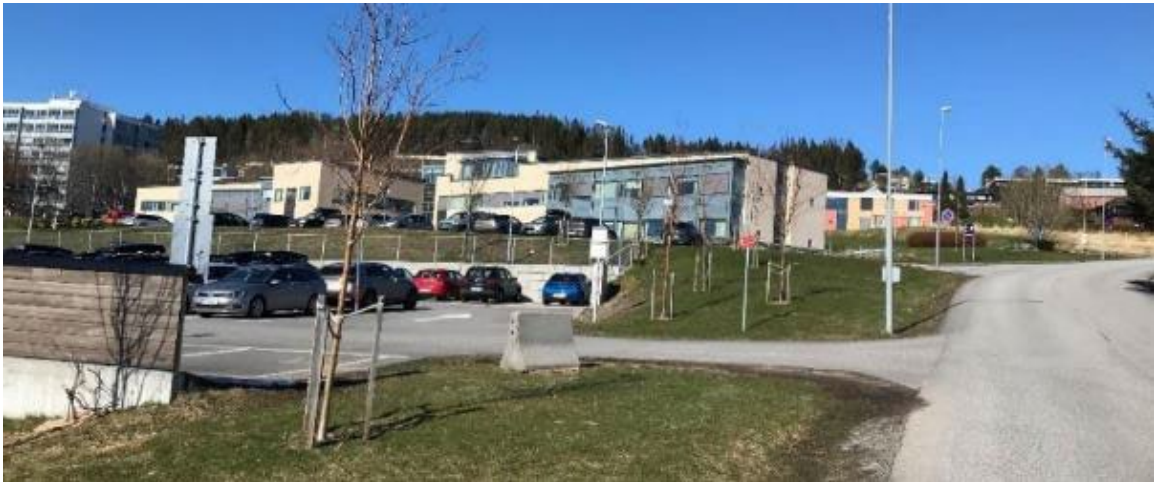
Figur 17. Midlertidig parkeringsplass og BUP sett fra Geilebergvegen, lengst øst i planområdet. Grøntdraget Åsemulen sees i bakgrunnen.
