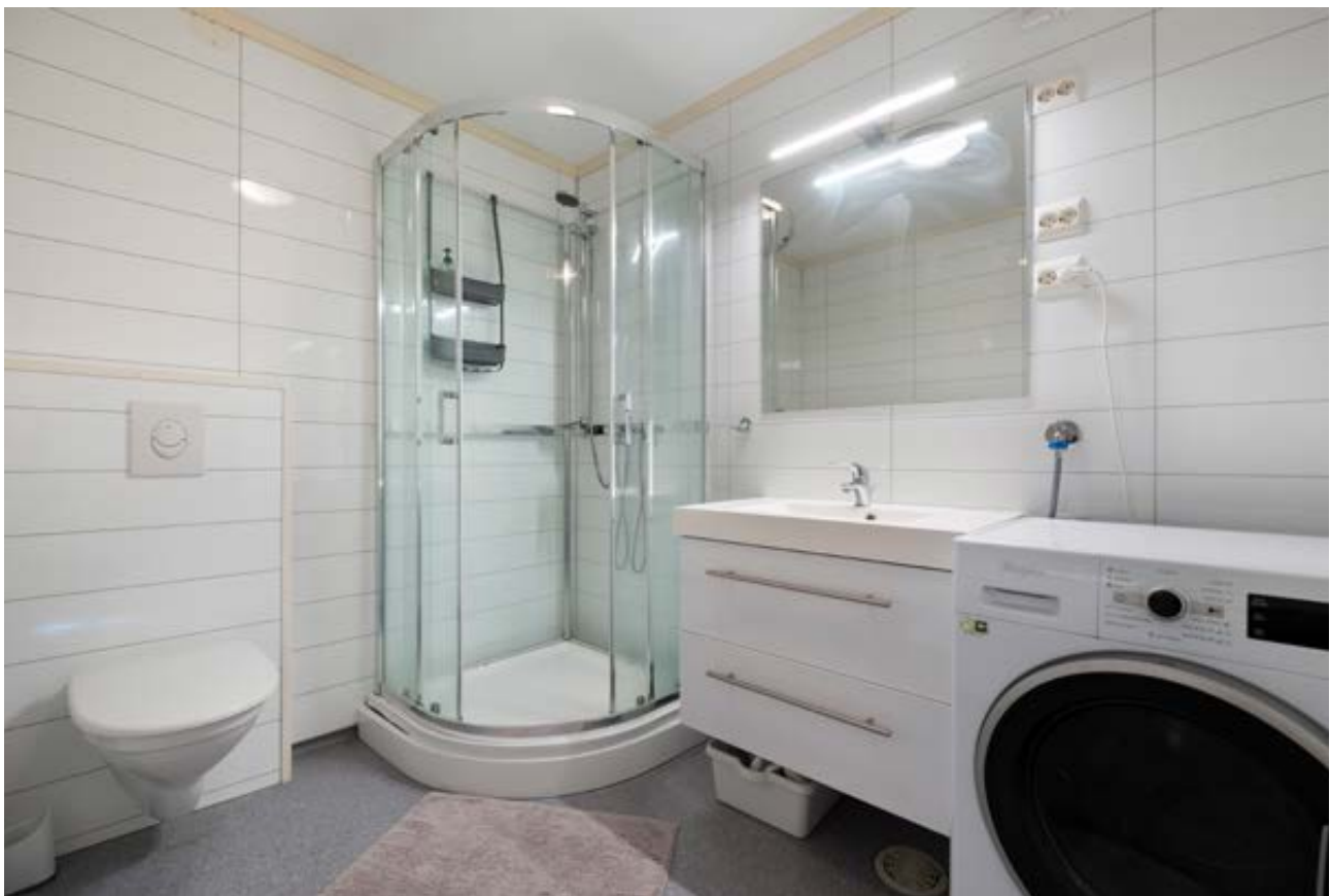
Bad som ble laget til nytt i 2016. Opplegg for vaskemaskin på badet
