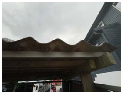
Eternittplater på takoverbygg terrasse.
