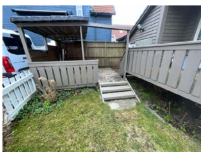
Eternittplater på takoverbygg terrasse.
