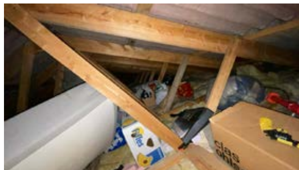
Plassbygde w-takstoler med kaldloftskonstruksjon.
