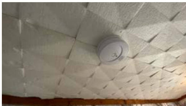
EPS i tak i gang hovedetasje.
