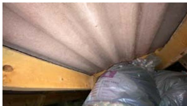
Opprinnelig takteking fra byggedato fungerer som undertak.
