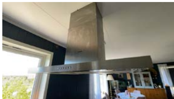
Takhengt ventilator over kjøkkenøy.
