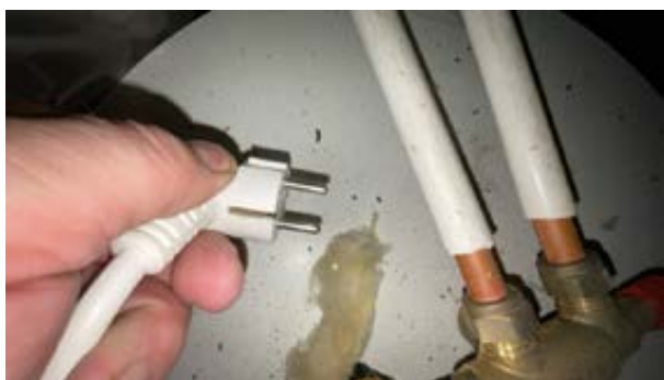
Ingen svimerker på stikk ved dagens befaring.
