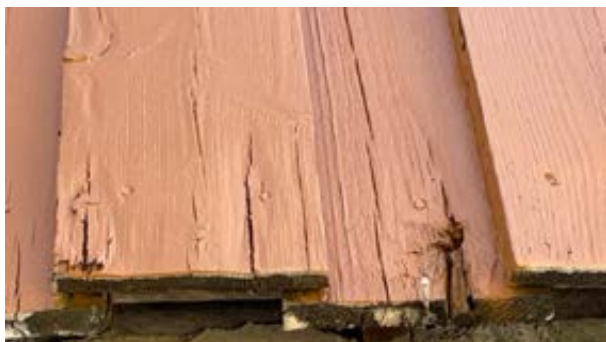
Stedvis sprekk/råteskader.
