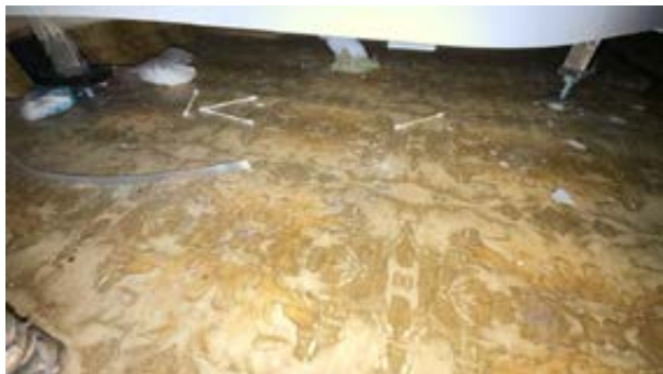
Det er ikke etablert sluk i gulv.
