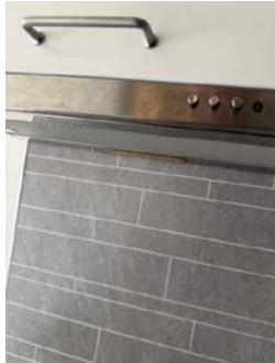
3. ETASJE (H 0302) > STUE/KJØKKEN
