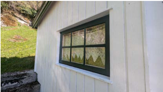
Vindu med koblet glass på toalett.
