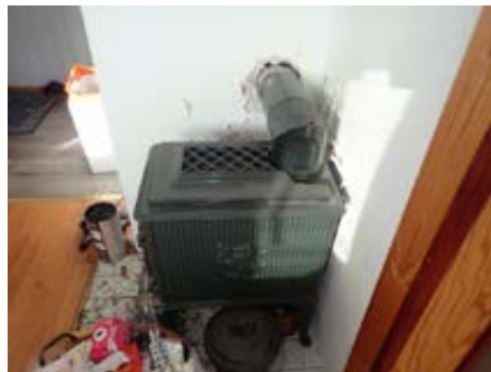
Nært plassert mot brannmur.
