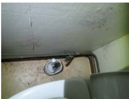
Vannrør gjennom belegget.
