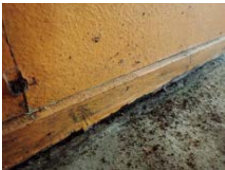
Fuktskadet vegg
