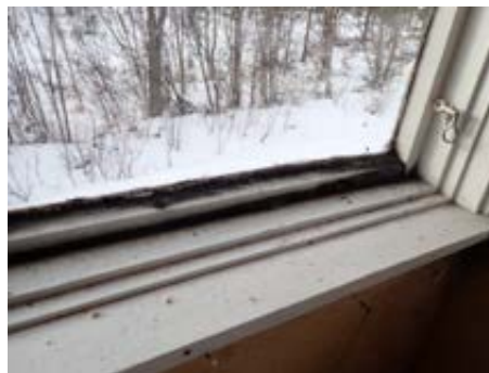
Vindu i rommet over vf.
