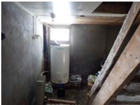
Rekkverk-bord med muggsopp
