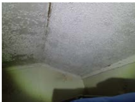
Fuktskadet baderomstak.
