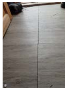
Sammenhengende laminatskjøt i vf
