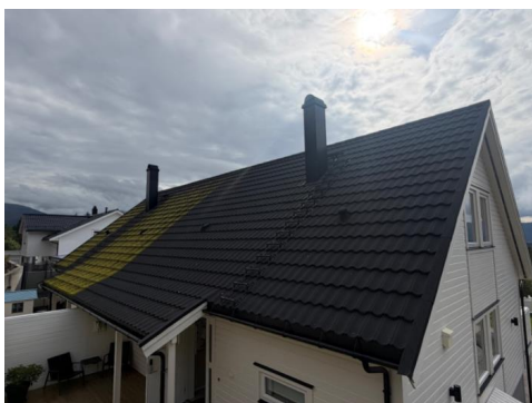
Oversiktsbilde av taktekkning mot nord.
