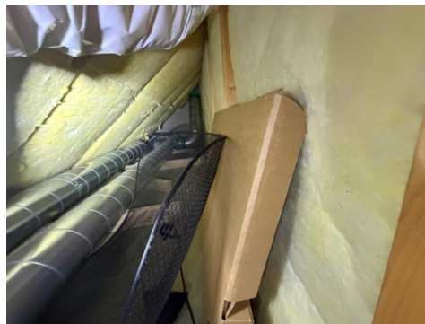
Oversiktsbilde, ett av raftekottene.
