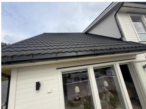
Oversiktsbilde av taktekkning mot sør.
