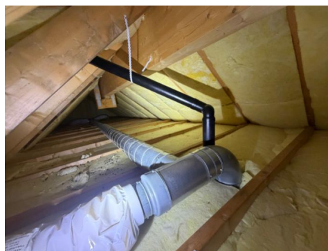
Oversiktsbilde av loftet.
