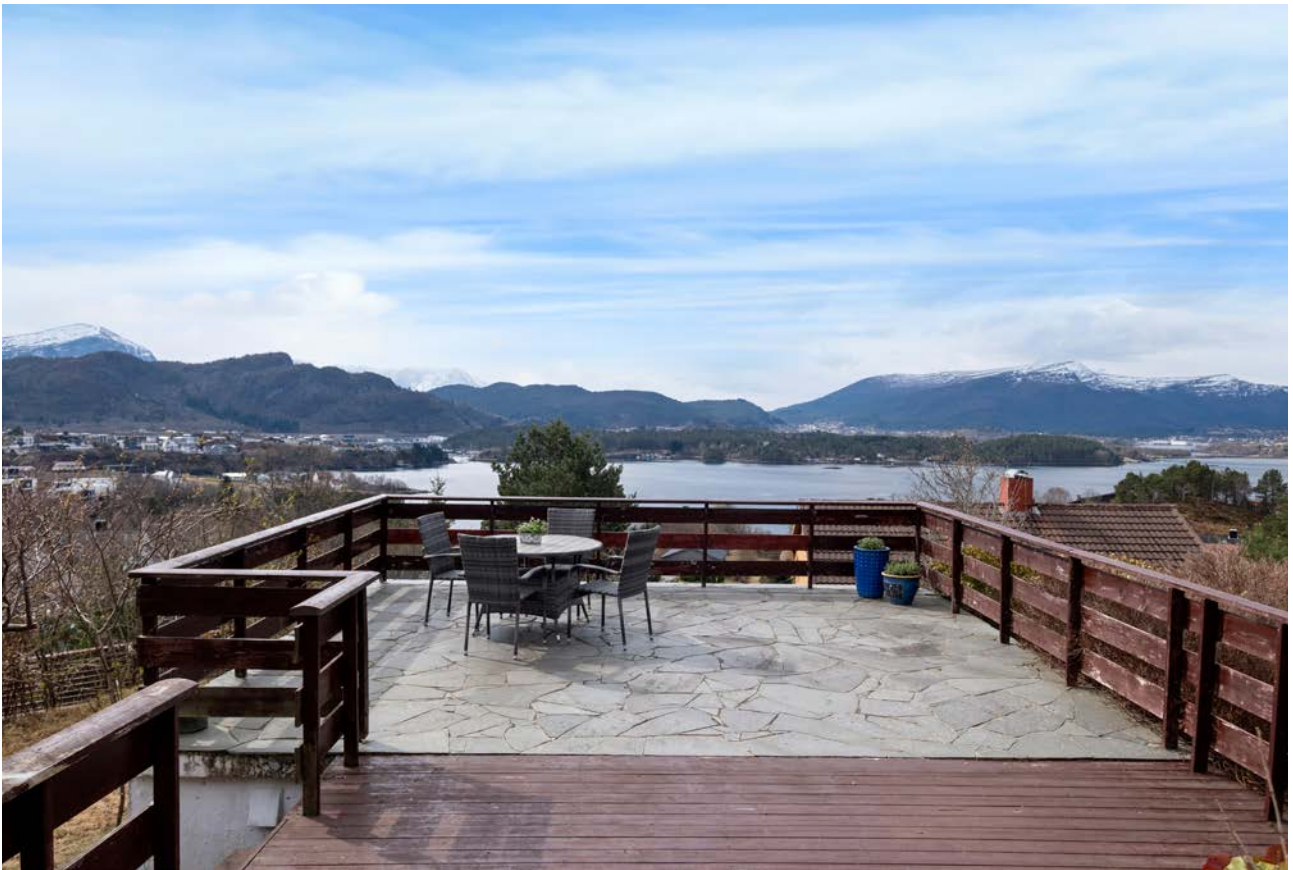
Terrasse på garasjetak
