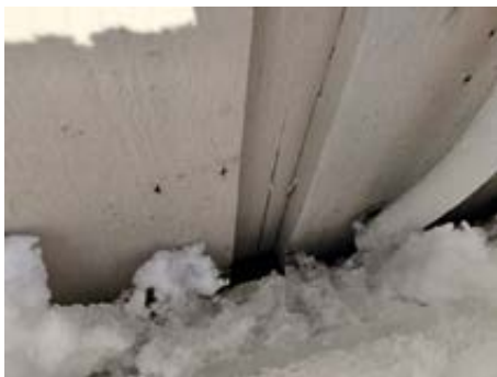
Sprekk i kledning.
