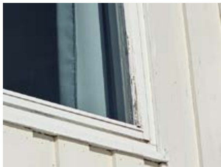
Det er tegn til kondensering innvendig på enkelte vinduer.
