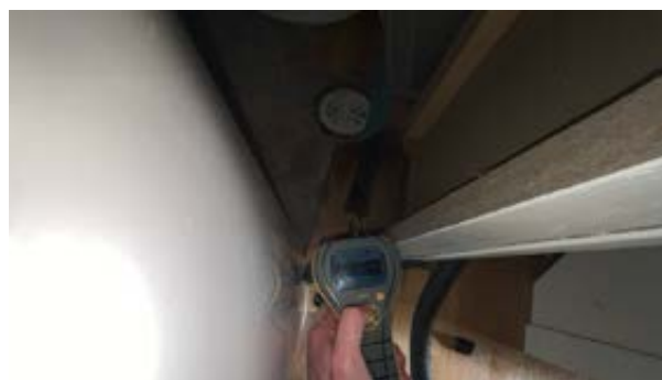
Ikke målt unormale fuktverdier.
