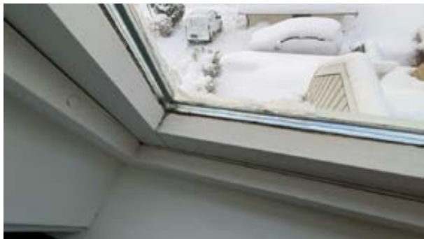
Det er tegn til kondensering innvendig på enkelte vinduer.
