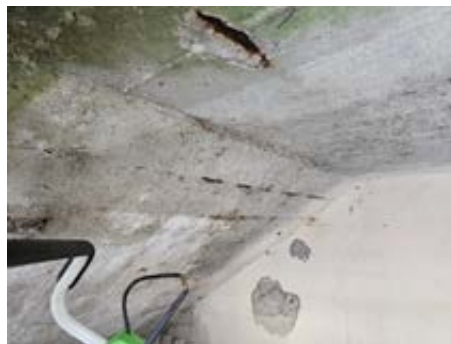
Eksponert armeringsjern under trapp.
