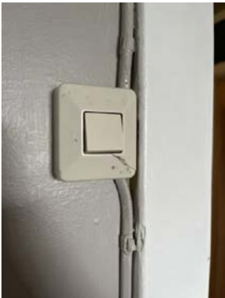
Sprekk i deksel på bryter
