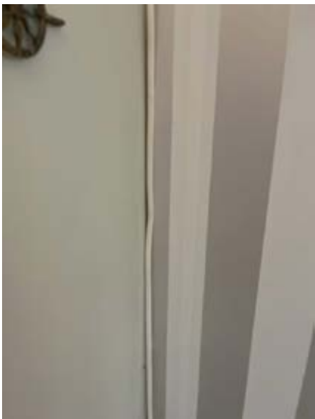
Sprekk i deksel på bryter
