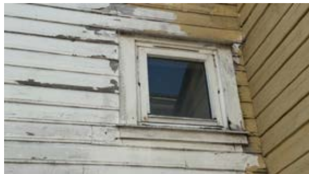
Baderomsvindu 1.etg. fra 1979
