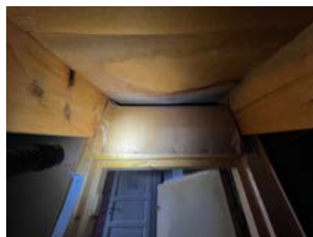
Luftesplate mellom undertak og isolasjon i takkonstruksjonen.
