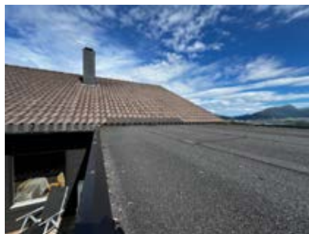
Oversiktsbilde av taktekking.
