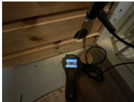
Hulltaking og fuktsøk.
