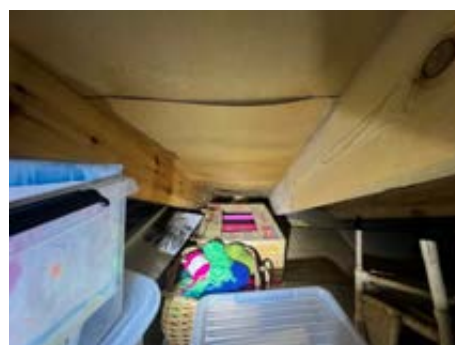
Luftespalte ut til det fri.
