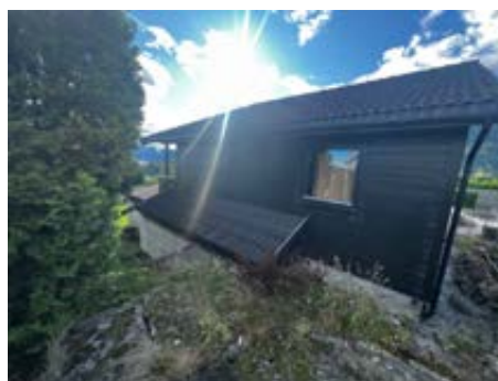
Oversiktsbilde av taktekking.
