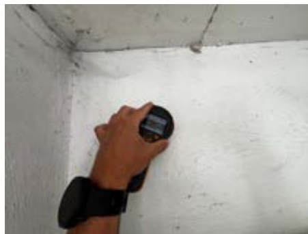
Fuktsøk på grunnmur i garasje som ligget mot terreng. Ikke utslag på fukt i øvre del.
