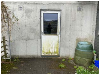
Dør til bod under garasje fremstår som vær-slitt.
