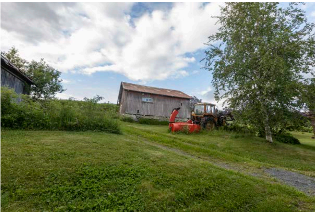
Uthus i enkel standard benyttet til lagring, oppført i reisverk på natursteinsmur
