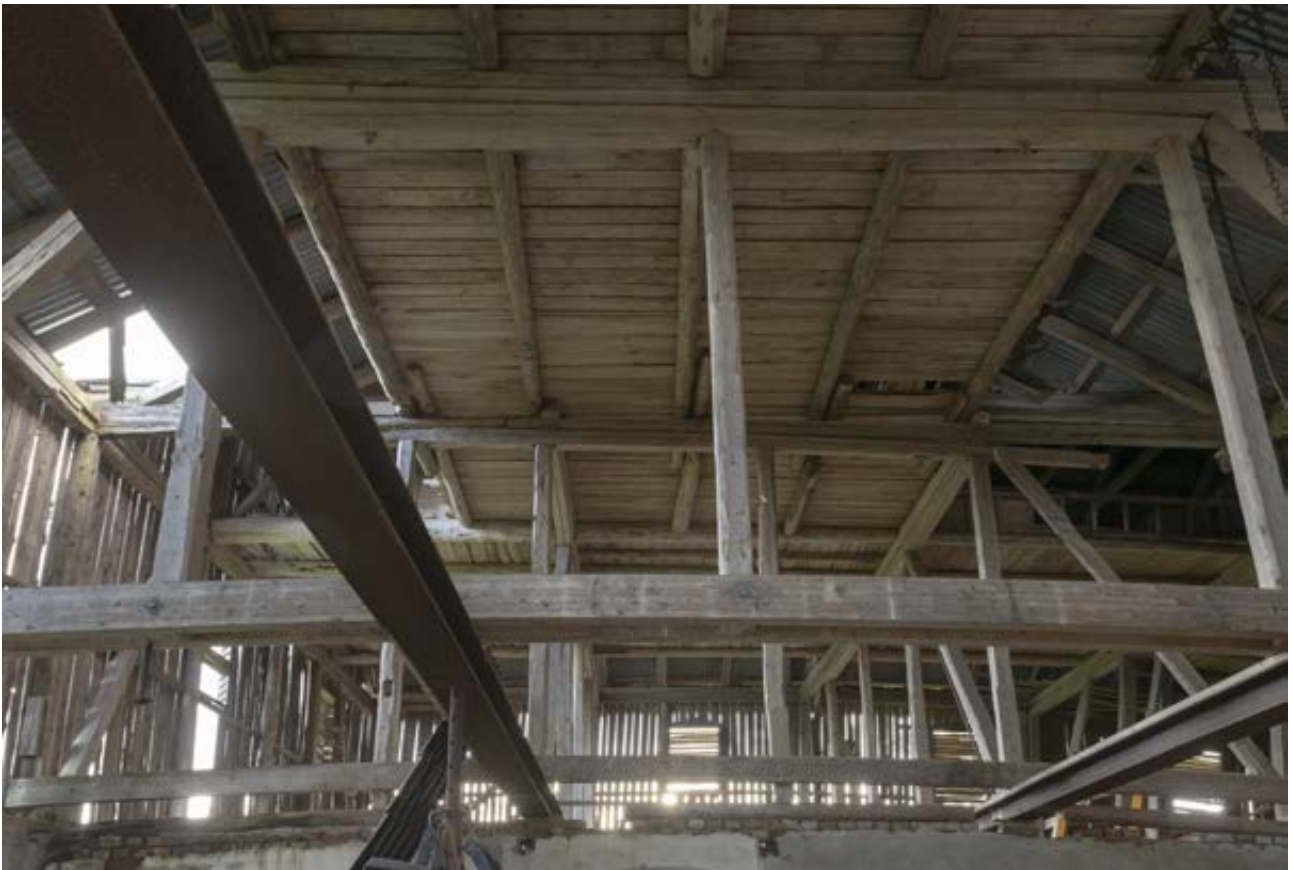
Tradisjonell driftsbygning med fjøs, mellomlåve og kjørebru.
