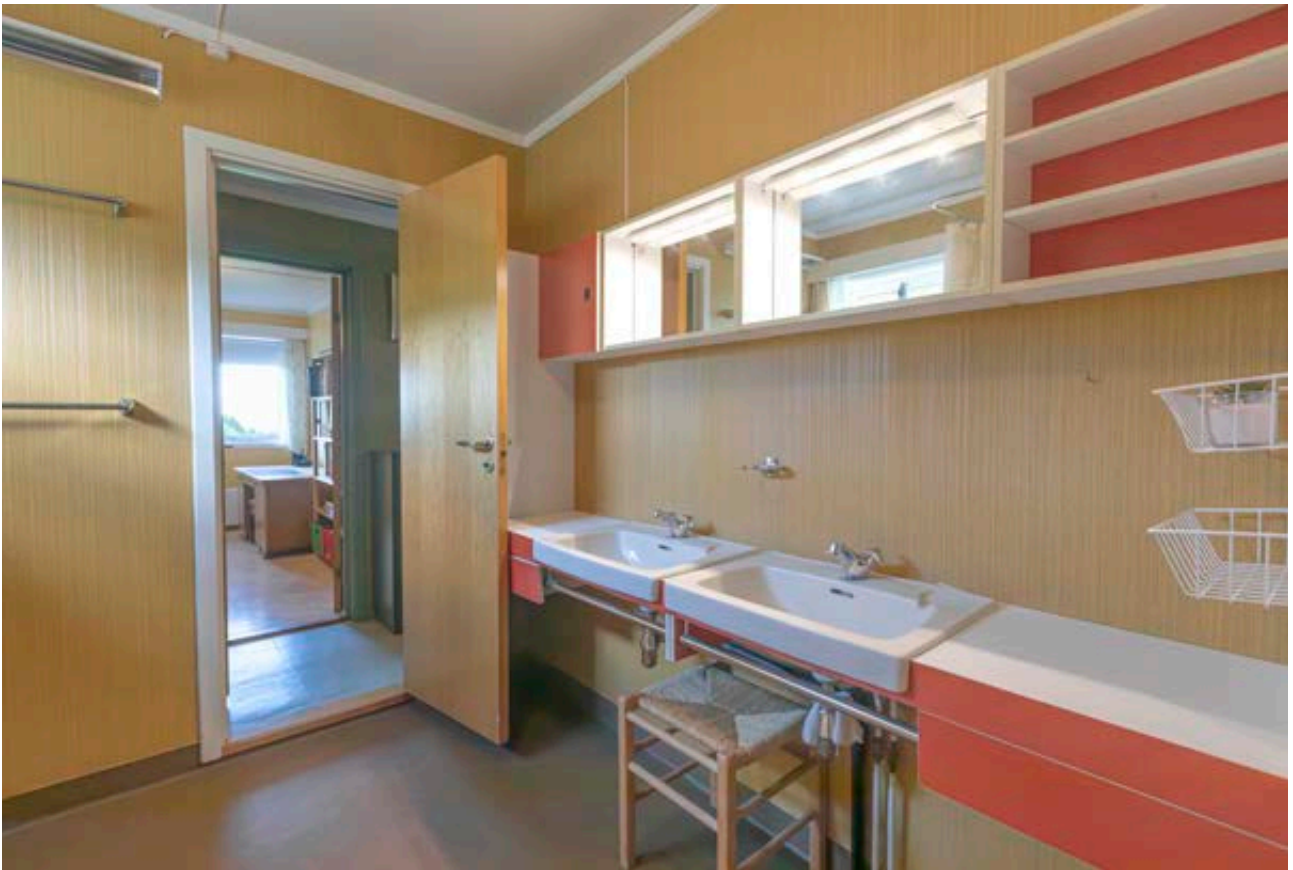
Bad i 2. etasje med vinylbelegg på gulv, våtromstapet på vegger, elektriske varmekabler og badekar med dusjløsning.
