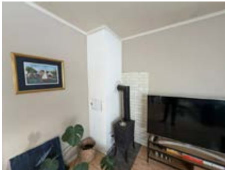
ildsted og sotluke i stue i kjellerleilighet.
