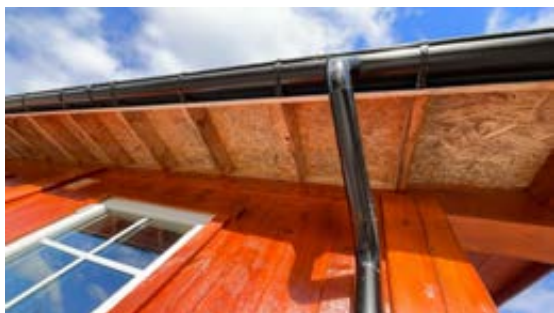
Synlig lufting ved takrennekroker.
