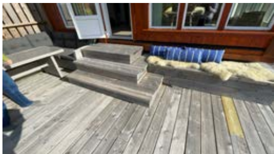
Trapp ved balkongdør.
