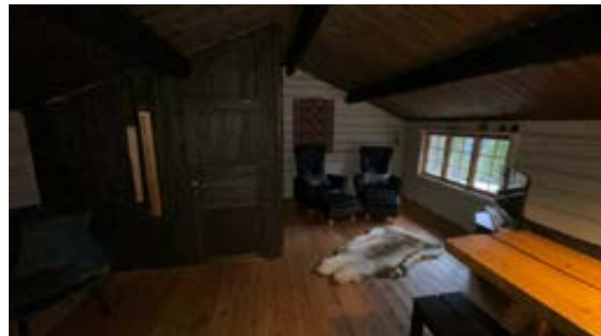
Takkonstruksjonen har sperrekonstruksjon med takåser av rundstokker og sperrer.
