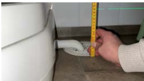
Høyde ved sluk.
