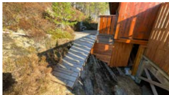
Rampe for tilkomst terrasse ved hovedytterdør. Det mangler rekkverk.
