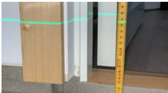
Høyde gulv ved dørterskel. 2 mm over sluk.
