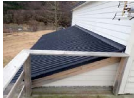
Tak over inngangsparti
