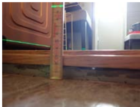
18 mm mellom flis og dørstokk Ikke synlig membran.
