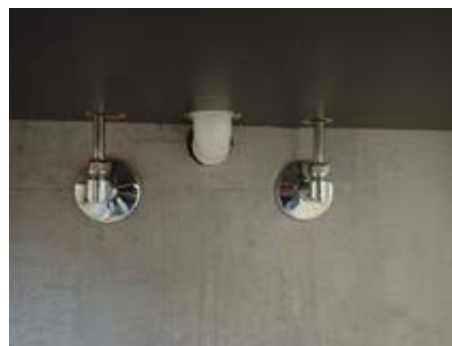
Vann/avløp til/fra servant. Åpent hull i vegg
