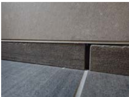
Store avvik - åpning mellom aluminiumsflit og veggplate.
