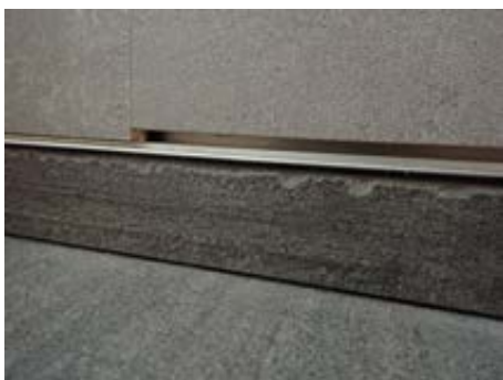
Store avvik - åpning mellom aluminiumsflit og veggplate.
