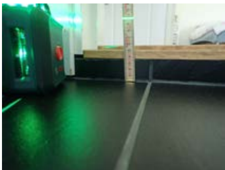
Høyde ved dørterskel
