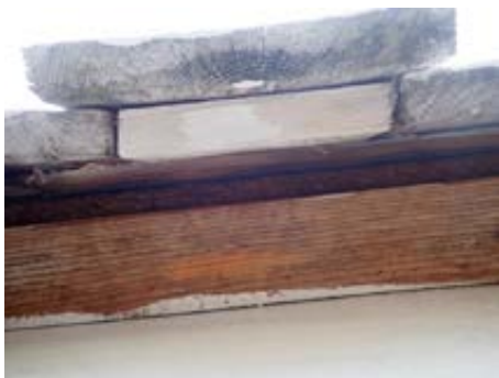
"Luset" mellom underliggerne
