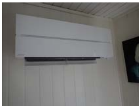
Varmepumpe luft til luft
