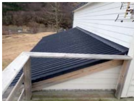
Tak over inngangsparti
