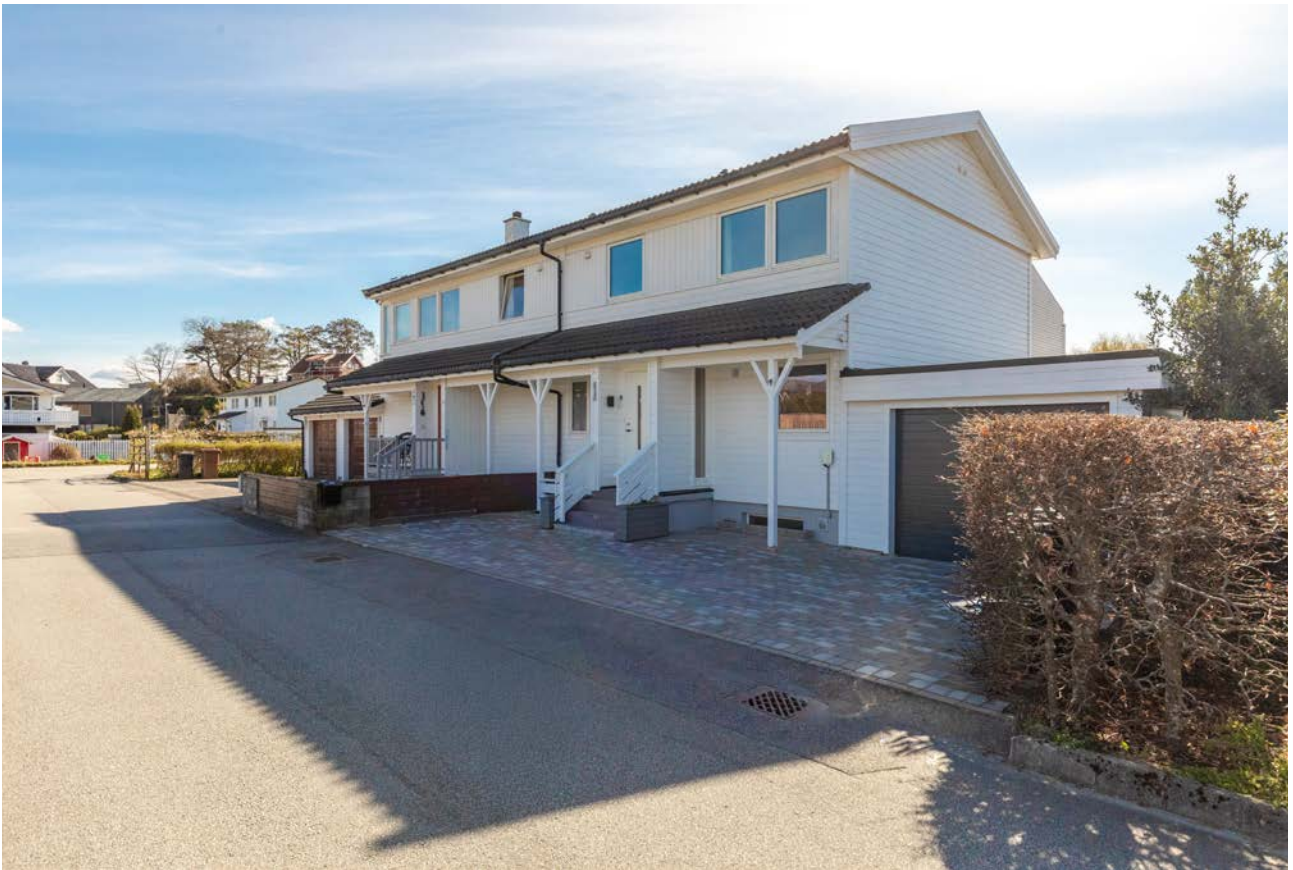
Fasade - belegningsstein i gårdsrom
