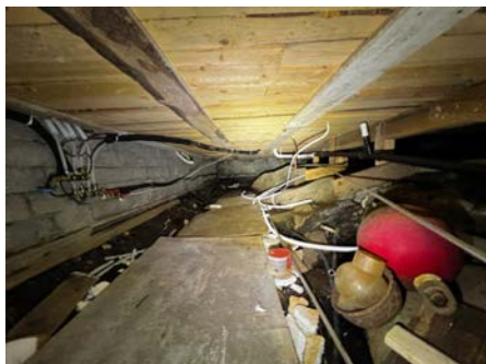
Det er målt 19,3 vektprosent i stubbegulvet.
