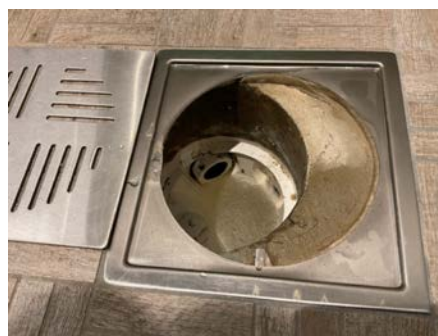
Sluk, tykk påstøp over sluken.
