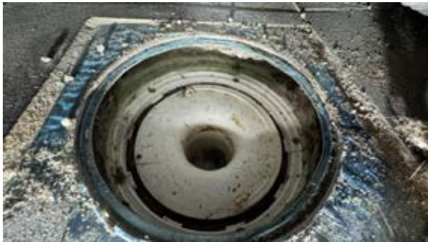
Synlig klemring og smøremembran.
