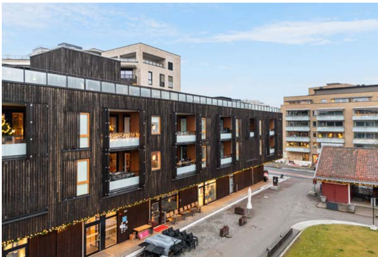
Inngangspartiet på boligblokken leder ut til Lillo Gård.
