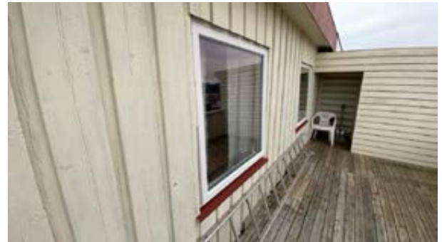
Vinduer mot syd.
