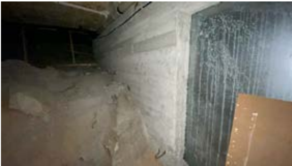
Plasstøpt betong rett på fast fjell.
