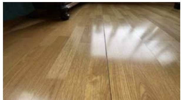
Stedvis gliper/skade på laminat.
