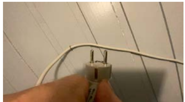
Ingen visuelle svimerker på stikk ved dagens befaring.
