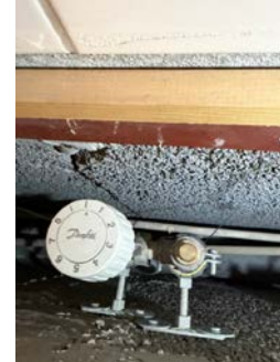
Justering av vannbåren varme i baderomsgulv
