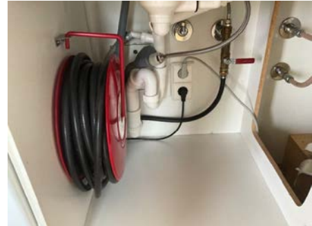
Besiktigelse av røropplegg.
