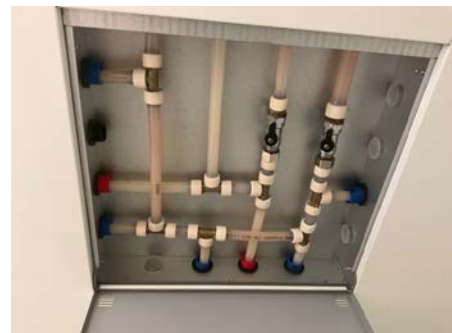
Besiktigelse av røropplegg.
