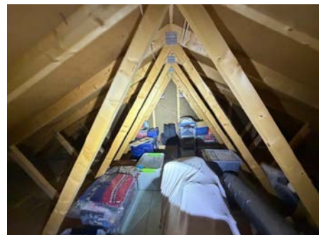
Oversiktsbilde av kaldloftet.
