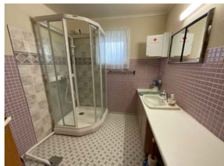
Oversiktsbilde av badet.
