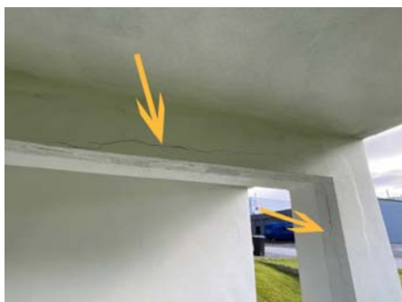
Spekk i betongbjelke og søyle.
