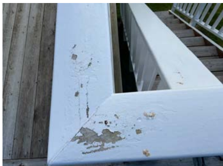
Noe værslitt rekkverk.
