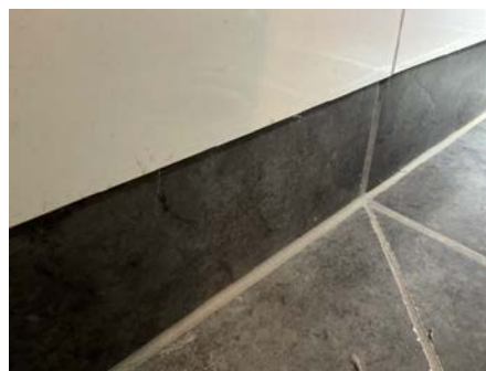
Ufagmessig montering av våtromsplater.
