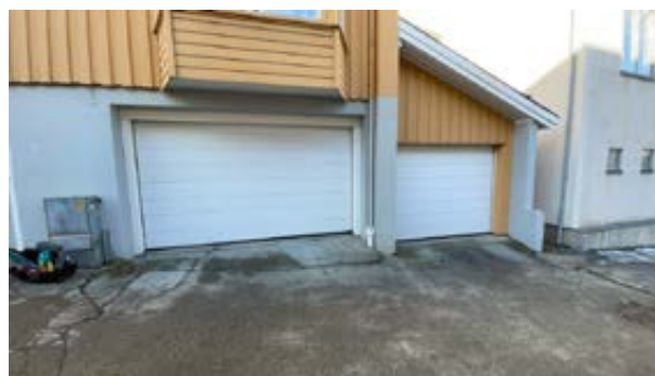
Garasjeport (til høyre)
